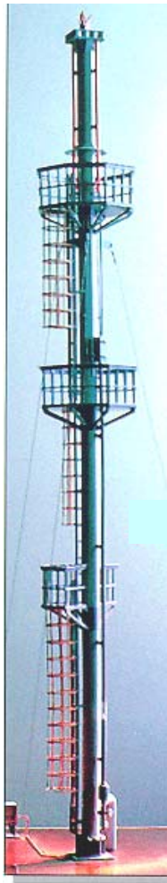
Рисунок 1 – Общий вид факельной установки.
